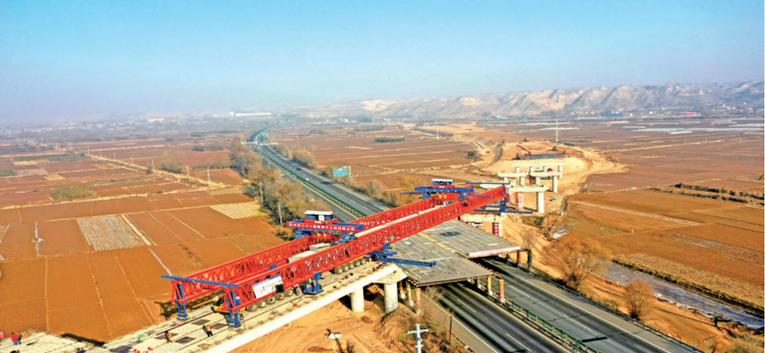
4月7日，随着洮河大桥最后一片箱梁的准确就位，由三公司承建的安临公路1标项目洮河大桥箱梁架设全部完成，成功实现对G75兰海高速的跨越。洮河大桥全长888米，由17跨波纹钢板桁梁组合梁和23跨混凝土预制箱梁组成，是安临公路全线重点工程。洮河大桥不仅一桥通两县，北接临洮县，南连东乡县，更是疏通定西市与临夏回族自治州关键通道。
