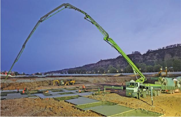
4月8日，在脆响的爆竹声中甘肃省国家体育训练基地足球训练基地垫层浇筑工作开始实施，标志着临洮体育训练基地二期建设进入了实质性施工阶段。图为施工现场机械操作人员、地面施工人员熟练配合，进行混凝土垫层浇筑工作。
